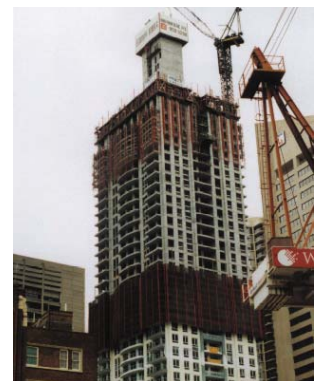
▲50階の高層ビル(シドニー) Taylor & Herbert Consultants
