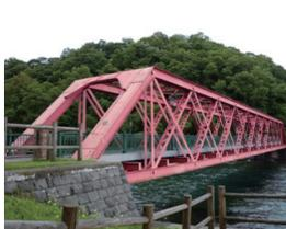
北海道を代表する湖の一つである支笏湖に日本の橋梁史で貴重で重要な遺産として現存されているのが、湖畔橋である。明治15年英国より招聘された技師長ボナール氏の設計によるもので、当時は官設鉄道上川線に架けられていたが、その後は輸送量の増加により、架け替えられ更には王子製紙の軽便鉄道として活用され、現在は湖畔橋として「歩道橋」となり、地元民に親しまれている橋である。
