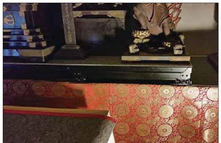
■免震レトロフィット工法研究会に所属する NewsT 研究所が開発した軽量・薄型免震装置。写真は鎌倉・明王院の本尊 不動明王の下に設置されたもので、文化財展示の他にも医療系装置等でも活用されている
