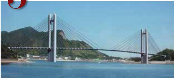
離島同士の合併により誕生した上島町の生活基盤強化と産業活性化等を目的として「上島架橋整備事業」として2011年2月の開通した。建設コスト縮減の為、主塔を鉄筋コンクリート製で中央径間はPC桁と鋼桁の混合構造で、鋼桁の防錆では耐久性のあるアルミニウム・マグネシウム合金溶射採用等、色々な工夫がなされている。現場架設はFC船による張出架設法で、最終の併合桁ブロックは色々な工夫で落とし込み併合した。残る岩城島と生名島の架橋が待たれる昨今である。
