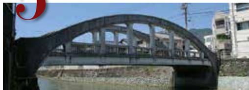
初代の明治橋は、明治37年に建設され、鉄橋のような木製トラス橋であった。その後、昭和5年に現在の鉄筋コンクリート製アーチ橋に架け替えられている。地元出身で「飛行器」の発明で著名な二宮忠八翁がこの橋のたもとで「忠八鳳」を飛ばしたことに思いを馳せるのも楽しみがある橋である。土木学会で平成22年推薦土木遺産に認定された。
