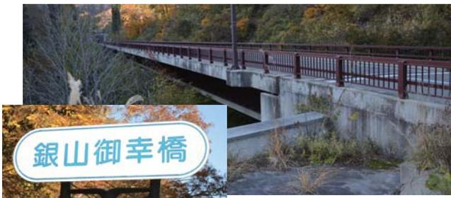
本橋はPC橋の主桁(ウェブ)のコンクリートを波形鋼板に置き換えたコンクリートと鋼の複合構造で、日本初の本格的な波形鋼板橋である。斬新な設計と景観や環境に対する配慮が評価され、土木学会田中賞や土木学会デザイン賞優秀賞を受賞した。
