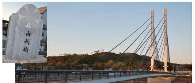
住民から「ゆりきょう」と呼ばれ親しまれていた旧トラス橋の老朽化に伴い県内初の斜張橋に架け替えられた本橋は、主塔や欄干をライトアップするなど市民にいつまでも愛され続けられるように工夫されている。下校時の学生達の雑踏にも橋の世代交代が感じられた。
