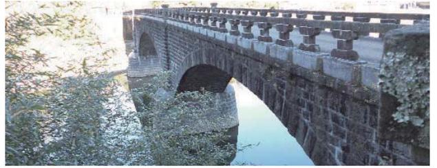
羅漢寺橋は、一つの脚間が26mもの大きなアーチを持つ日本で2〜3番目に長い橋。この橋の特徴は脚間と高さの割合が5.0という非常に扁平なことで、それだけに応力バランスが難しく、架設も困難をきわめた。完成までに2回にわたる崩壊があった。1920年に完成。
