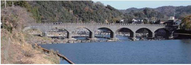
山国川に架かり「青の洞門」の下流約500mに位置。橋長116mは石造アーチ橋として国内最大で、8連石造アーチも我が国唯一。大分県や熊本県の石橋とは異なり、長崎の石橋に多い水平石積みを採用しているため、地元では「オランダ橋」と呼ばれる。大正12年(1923)完成。大分県の有形文化財に指定。
