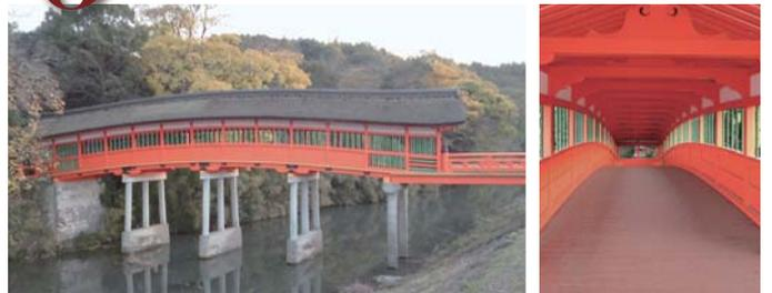
呉橋は鎌倉時代より前に存在していたといわれている。呉橋(くれはし)という名前は中国の呉の人たちが架けたといわれ、橋の名前になった。この橋が架かる参道は昭和初期まで表参道であった。上部は木造で、3基ある橋脚は石造、屋根は向唐破風造で檜皮葺(棟は銅瓦葺)。平時は渡ることができず、10年に一度の勅使際の時に使用される。
