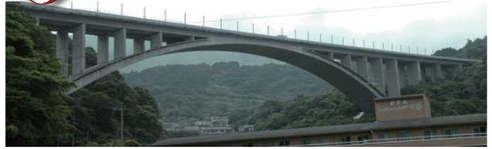
九州横断自動車道 別府IC～湯布院IC間に位置、別府市郊外の幅400mのU字の谷をまたぐために架けられた道路橋。明礬温泉は、強酸性の温泉脈が流れており、地表面には硫黄を含んだ蒸気が噴出、鉄はすぐ腐食し、コンクリートでもボロボロになってしまう。谷部には橋脚が設置出来ず支間235mの鉄筋コンクリート固定アーチで建造。平成元年（1989）完成。土木学会、田中賞受賞。
