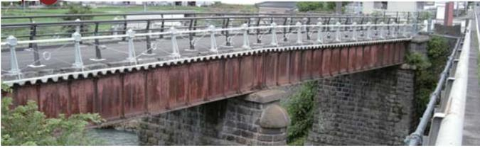
架橋当初の位置にある現役の鋼橋としては、日本最古の橋。架設当時、日本で製鉄は行われていなかったため、イギリスから輸入されたDorman Long社製の鋼材を使用。また、橋梁床板の先駆けといえる合理的な合成床板（鋼板の上にコンクリートを打設）を施工、明治35年（1902）完成。平成17年（2005）、土木学会選奨土木遺産、県の有形文化財に指定。
