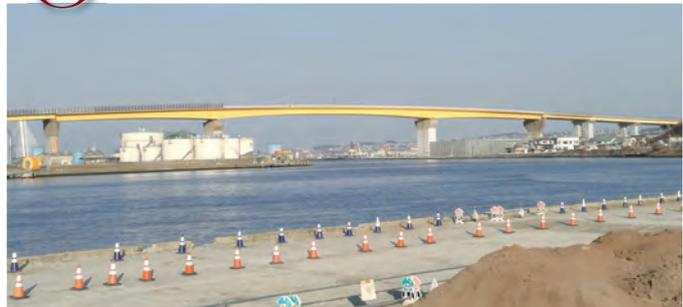
八戸市を代表する橋の一つで、市民からは夢の大橋として親しまれています。青森県で一番長い橋梁で、八太郎大橋と共に八戸港の沿岸部の港湾道路を繋いでいます。八戸港に入港する漁船を考慮して、水面から橋桁まで30mの高さで、中央径間は165mに及び、耐候性鋼材で施工されています。
