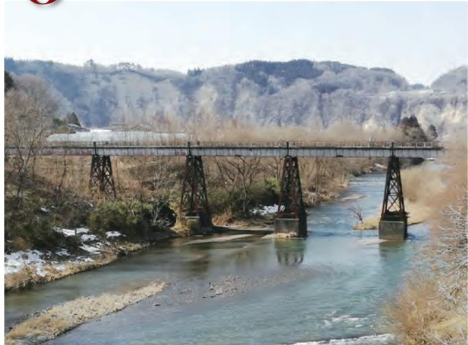
青森と岩手の県境で馬淵川にかかる橋。道路橋としては珍しいトレスル橋脚（高さ12m）で、橋面は鉄筋コンクリート。1935年（昭和10年）に架けられ、国道4号を通したが、後に青岩バイパスの青岩大橋に役割が交代しています。2010年（平成22年）7月16日にJR西日本山陰本線の旧余部橋梁が供用を停止してからは、日本最長のトレスル橋となっています。現在は老朽化が進み車両が通行止めとなっています（歩行者は通行可）。平成18年土木学会選奨土木遺産。
