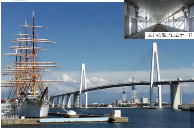
射水市の富山新港に架かる日本海側最大の2層構造の斜張橋。橋は5径間連続複合斜張橋で、2車線の車道階と桁下の自転車歩行者道階の2階建て構造からなります。上層の車道は自動車、原動機付自転車専用道で2車線、また車道には下水処理水を利用した融雪装置が設置されています。下層には長さ480m、幅約3m、ガラスで覆われた全天候型の愛称「あいの風プロムナード」と名づけられた自転車歩行者道が桁下に設けられ、エレベーターにてアプローチできます。
