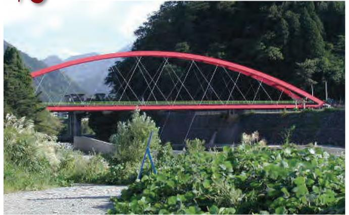
黒部市宇奈月町の黒部川中流に架かる県道13号朝日宇奈月線の橋。現橋は、1969年(昭和44年)8月11日の豪雨で、流失し架け替えられた12代目です。元の位置から少し下流に、朱色に塗装された橋が架けられています。1998年(平成10年)には日本百名橋に選定されています。旧橋は、甲斐の猿橋と同じ形式の芻(はね)橋で、橋長33間、幅10尺で架橋されて愛本橋と名付けられました。両岸は岩山で上流部をのぞけばもっとも川幅が狭く、洪水時には大量の土石と水が集中し、橋脚が一年も持たずに流されてしまうために橋の中間に立てることが非常に難しく、川の両岸から大木を突き出す構造でありました。
