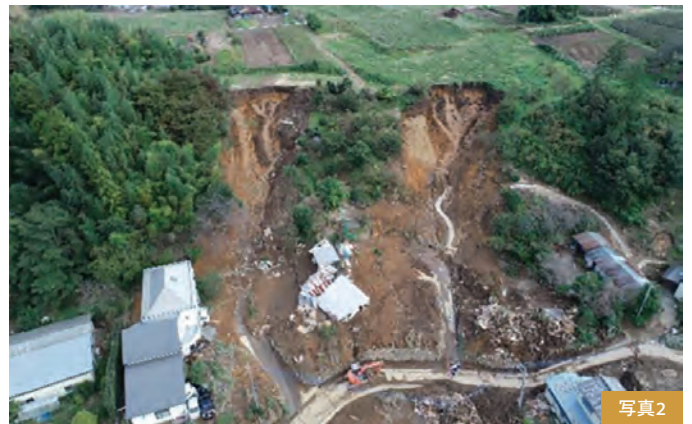
同左 による土砂崩壊(群馬県富岡町)崩壊6戸、死亡3名
