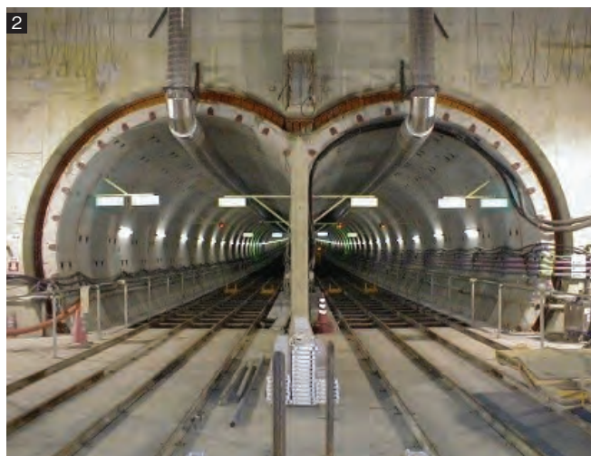
2 二連円形断面トンネルの完成
