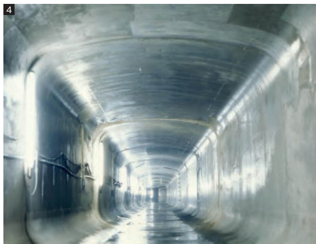
4 完成したトンネルの断面（ほぼ四角形です）
