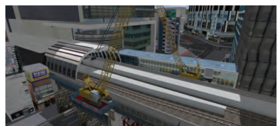
図11 渋谷駅の線路移設工事をシミュレーション
