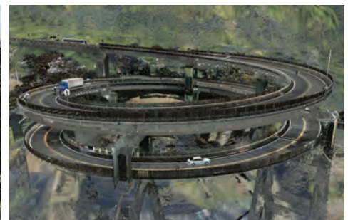
図 5 : 河津七滝ループ橋外観
