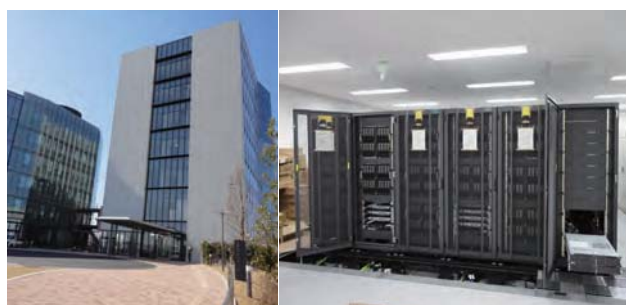
左：建設が進む「京」（計算科学研究機構）、FOCUS とは渡り廊下で接続される 右：FOCUS 内に設置が進むスパコン
