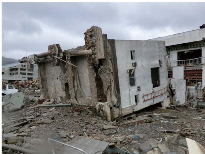
女川町内での被害状況。コンクリート建物が津波で倒壊（写真：今村文彦氏）
