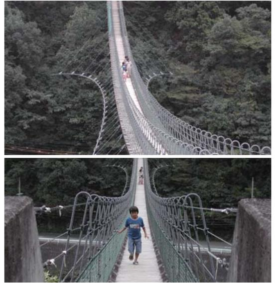
奈良県のほぼ中央、吉野郡黒滝村の「黒滝・森物語村」に黒滝・森物語村吊橋がある。黒滝川と県道を跨いで架かっていて、長さは約115m。湿った床板が歩く度にしなる。高さは約35mある。この黒滝吊橋は、吊床版橋と言って主ケーブルが直接床板を支えている吊り橋で、この形式の吊橋の中では日本最大級になり、床板の材質は黒滝村の特産品でもある吉野杉の丸太が使用されている。
