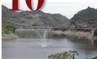
高山ダムの建設により水没した元の石橋(沈下橋)の代替として昭和43年1月竣工した重橋床式・鉸吊橋。古はここにも渡し舟の便があったが、昭和29年3月に石を渡した「沈下橋」が架設され、
