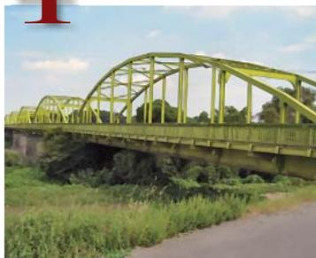
鬼怒川によって分断されている水海道市を繋ぐ重要な橋である。5つのアーチから成るこの橋は、美観上も優れている。老朽化が進んでいるため、全横荷重を下に伝える橋門構の部材を取りかえる等大規模な修復工事を行っている。長寿命化修繕計画により、維持管理の体制がきちんと取られている。交通の大動脈として重要な役割を果たしているが渋滞がひどく、この国道354号線に水海道バイパスを建設し緩和を図ることとなった。
