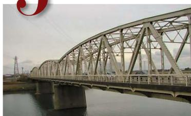
支間は3 @ 56m。昭和7年(1932)に国道6号(現在は旧6号)に架けられた。橋の老朽化が激しいため特定構造物改築事業として新しい橋が建設されている。なお、水戸市水府町の地名はこの橋の名称から取ったものである。
