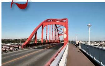
鋼単純下路ランガー桁+鋼単純合成鉄桁。那珂川河口に架かり、茨城県のひたちなか市海門町と東茨城郡大洗町を結んでいる。
