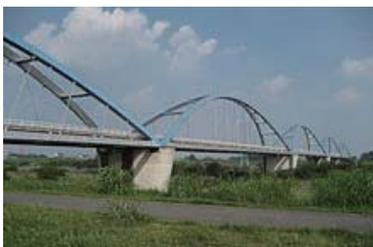
アーチ部は5連、685mである。三国橋の渋滞緩和のために建設された。建設は、平成12年(2000)である。国道354号のバイパスで、加須市柏戸交差点で分岐し、県道や東武日光線や渡良瀬川を跨いだうえ、古河市牧野地で再び合流する。
