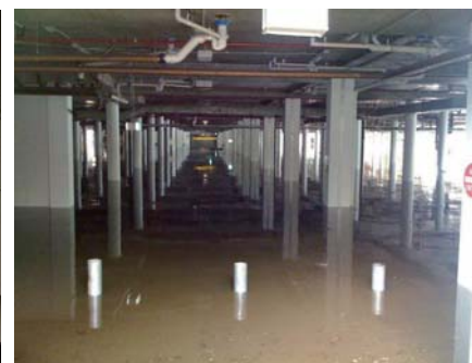
■図2 柱状建築基礎での浸水の例(：Queenbeyan, 2010年12月)
