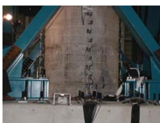
▲図4 橋脚基部の破壊状況
