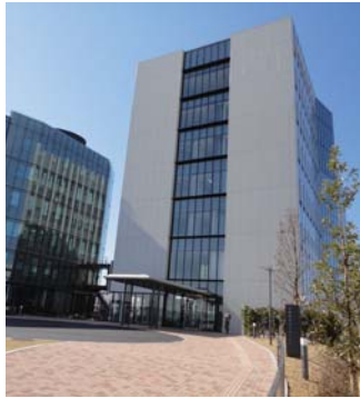
▲建設が進む「京」(計算科学研究機構)の建物
