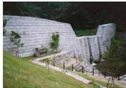
▲砂防堰堤の例。香川県内場川砂防事業。「不透過型」を採用している
