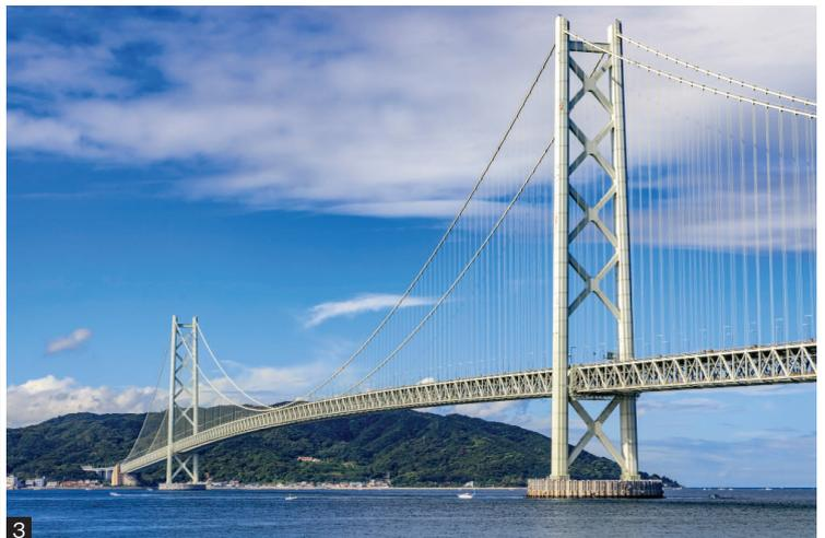
3 主塔の塔頂から見下ろす大パノラマ。既に、“怖い!”を通り越している。3 明石海峡大橋の全景。2つの主塔と補剛桁、メインケーブルとハンガーケーブルを確認されたい。
