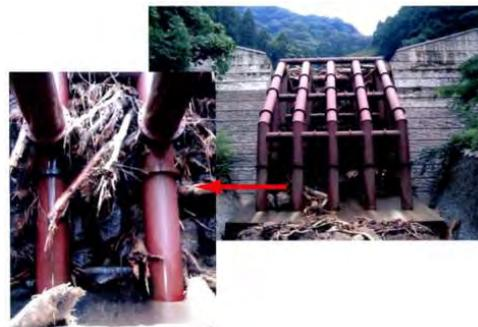
写真2 土石流等を捕捉して下流への土砂災害を防ぐ土石流対策事業(砂防堰堤)の一例
