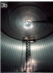
1 地上式としては世界最大容量のPCLNGタンク【提供 大阪ガス】 2 地上式PCLNGタンクの構造【提供 大林組】 3a 世界最大級のLNG基地 袖ヶ浦工場【提供 東京ガス】 3b 地下式LNGタンクの内部構造(側壁のメンブレンが光って見える)【提供 東京ガス】 4 地下式LNGタンクの断面構造【提供 東京ガス】
