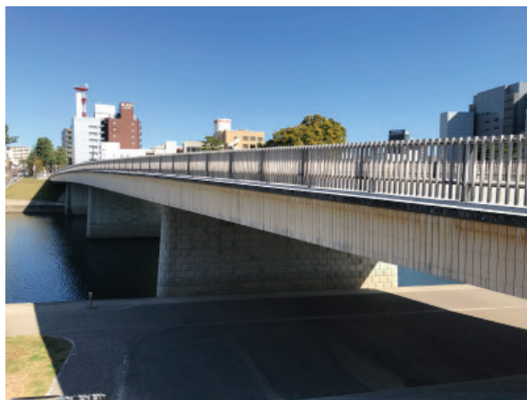
6 桜城橋の側面
