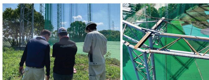
ゴルフ練習場の空撮点検
