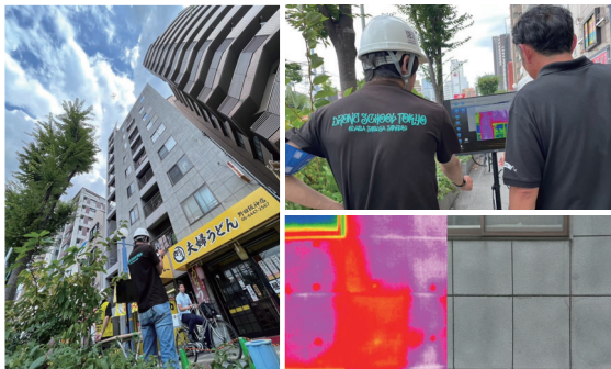
外壁調査・高所設備の定期点検
