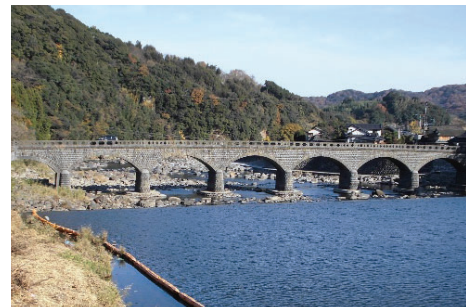
耶馬溪橋（石造り8連アーチ）
