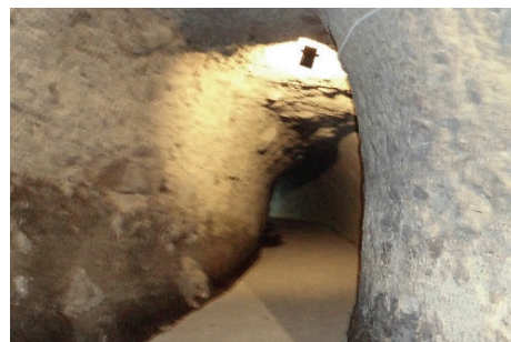
青の洞門 (現存する手掘り箇所)
