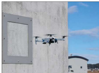
ドローンによる橋梁の損傷把握 【出典】国土交通省「点検支援技術性能カタログ」を拡充 報道発表資料(2026年4月)
