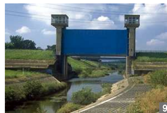
利根川からの導水を行う運河水門
