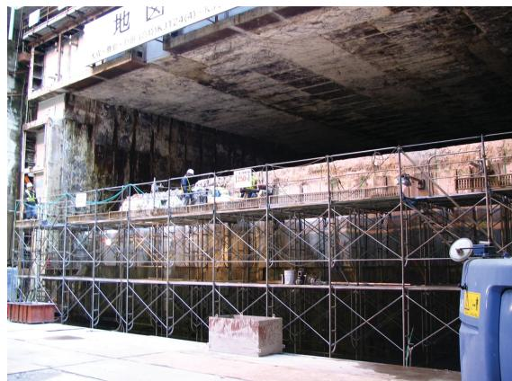
トンネル区間で採用された「MMST工法」による施工現場
