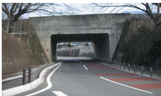
JR下を横断する県道のポックスカルバート。計画ではこの手前約10mのところにトラスの歩道橋が架けられる。
