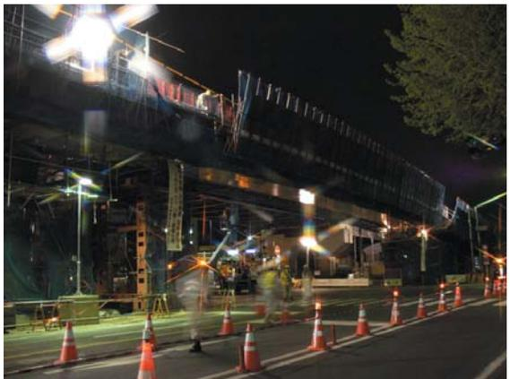
橋梁工事で「通行止め」を極力少なくする一環として街路を一晩通行止めにして実施された、ユニットキャリアによる一括架設。
