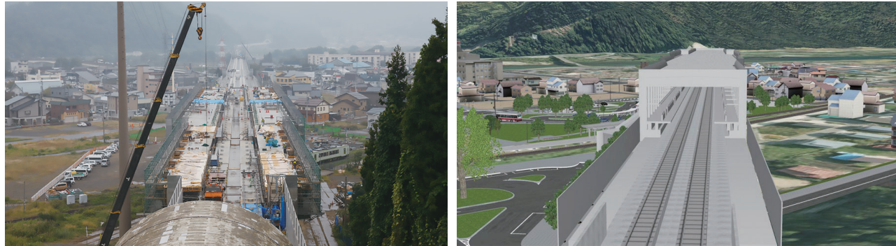
飯山駅全景建設中の現況(左)とVRデータ(右)
