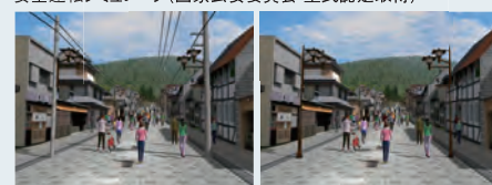
電線類地中化(対策前・対策後)
