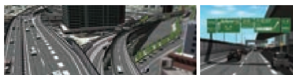
石川町ジャンクション (首都高速道路株式会社 神奈川建設局)
