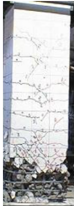
S20 試験体(曲げせん断耐力比 2.51, 曲げ破壊)
