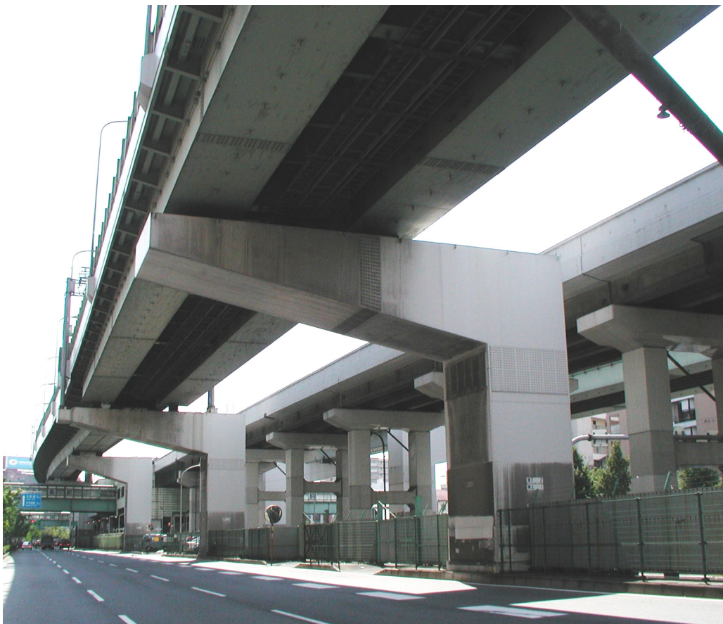
写真-2 鋼製逆L字型橋脚
