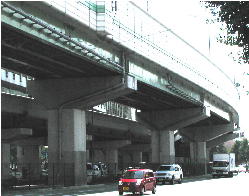
写真-1 RC製逆L字型橋脚
